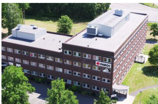
Figur 3. Byggnadens befintliga utseende.
